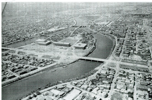
16 平和記念公園と元安川と街並み 戦後はバラック住宅で雑然としていた河岸も今はきれいになって、両岸には樹木が植えられ遊歩道と車道が整理されている。中央に平和記念公園があって、それを囲んで整然とした街並みが築かれていく。この写真は平和都市新生の象徴として最も力強く、美しく感じられる一枚である。
